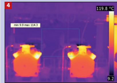
4 Thermografie der NK-Verdichter
